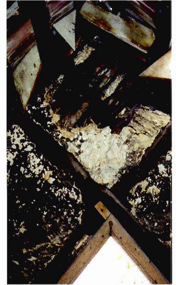
Blick in den Giebel, der zeigt wie man mit Flechtwerk die Ausfachung füllte.
