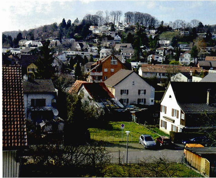
Der Blick aus dem Gemeindezentrum auf das Taunerhaus gibt einen Eindruck des Wechselspiels von alt und neu, und das Haus zeigt, wo der Eiter durchging.
